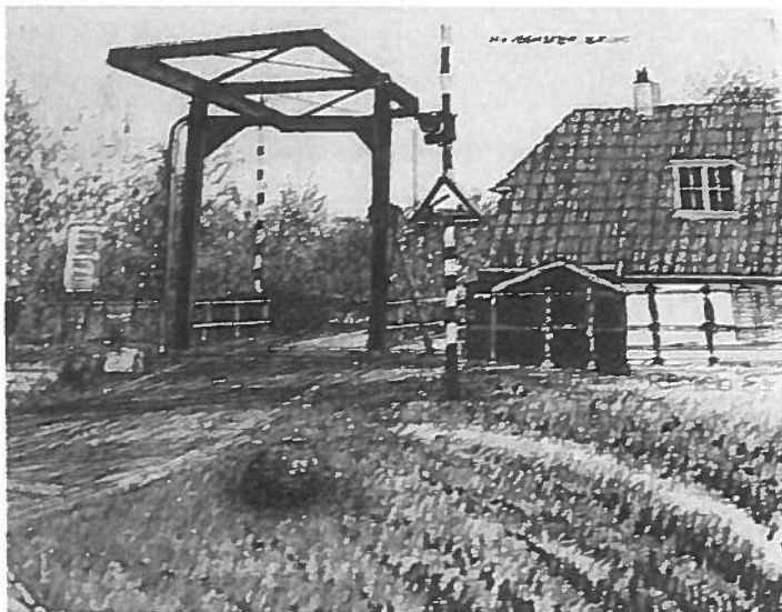
Nijveensterbrug bij de sluis
