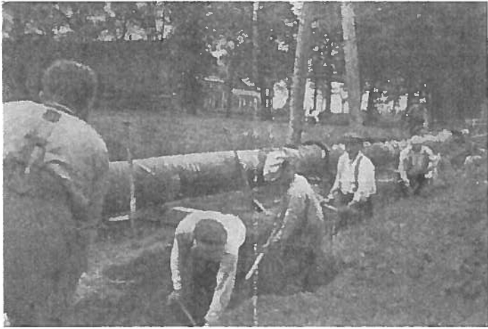
Aanleg buizen bij Noorddijk
