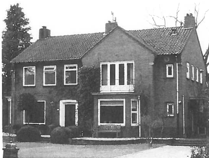
Twee-onder-een-kap woning aan de Westerse Drift 113-115 in Haren. Het linkerdeel heeft een betonnen rand rond de voordeur en erker met balkon opzij. Het rechtergedeelte heeft een erker met balkon bekroond met een topgevel. Let op de smeedijzeren balkonhekjes. De topgevels hebben een lichte uitkraging ter hoogte van de dakgoot, met een betonnen sierelement. De wc- en badkamerraampjes rechts in de voorgevel hebben een speelse baksteen rand
