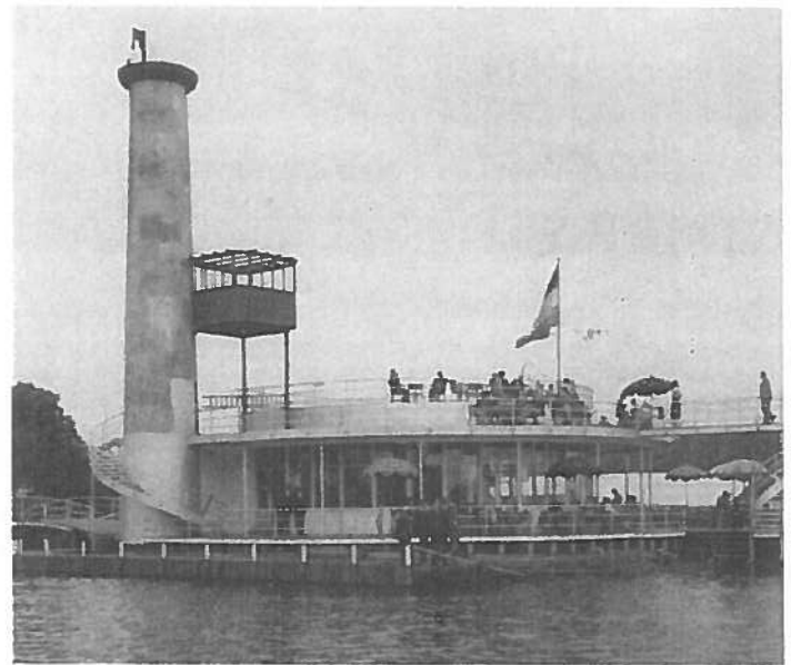
De toren van het Paviljoen de Twee Provinciën in aanbouw
