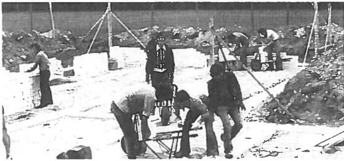
Leden leggen de fundamenten voor de bouw van het eerste clubgebouw aan de Oosterweg in 1977
