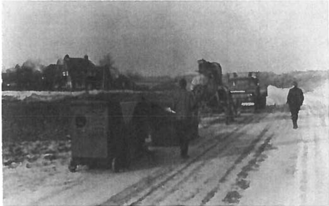
Werkzaamheden Meerweg, west van de A28
