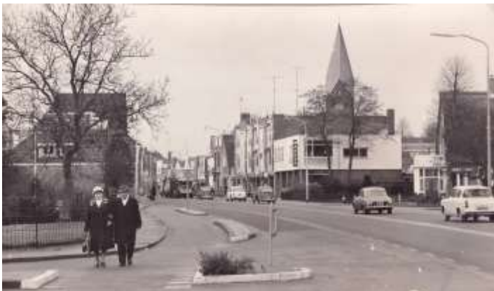
Beeld van de Rijksweg aan de zuidzijde van de dorpskom met rechts het pand van de fa. Wakker.
