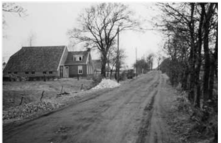
De Mellenssteeg tijdens asfalteringswerkzaamheden in 1965. Links het geboortehuis van Henk Bazuin. Dit is niet de boerderij die Jan Harms Bazuin in 1818 kocht. Deze boerderij stond 'om de hoek' aan de Oude Middelhorst.
