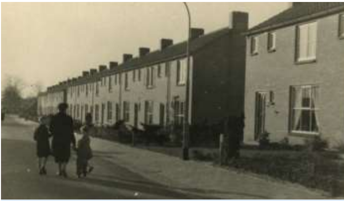
Woningen van het duizend woningenplan aan de Torenlaan (inmiddels afgebroken)
