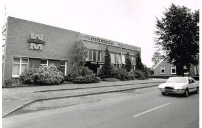
Het pand van Werkman Meubelen (voormalige zuivelfabriek) te Onnen kort voor de afbraak; foto Jan Buwalda
