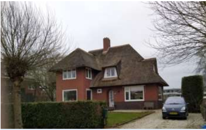
Een van de drie dubbele villa's aan de Meerweg
