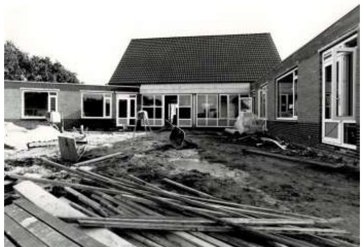
Bouw 'Ruige Hoek'; foto Jan Buwalda
